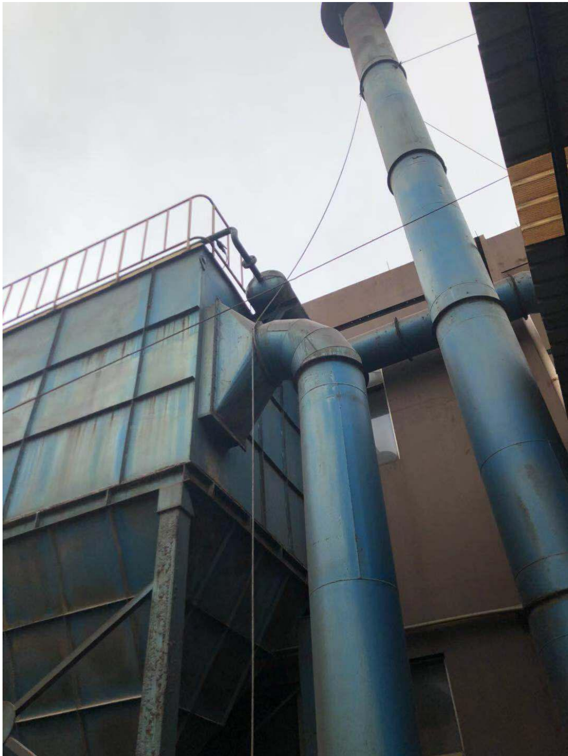
中频炉废气排气筒
